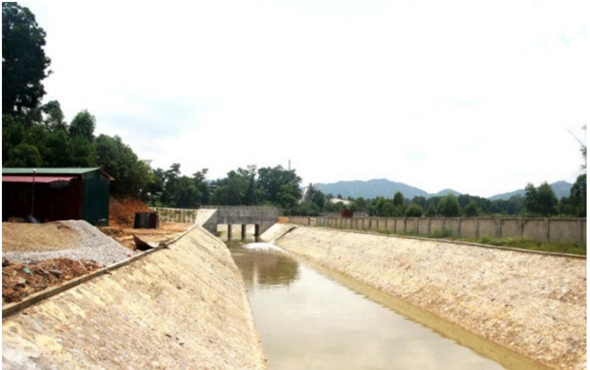
Nâng cấp, cải tạo nhiều công trình thủy lợi tại huyện Sóc Sơn
