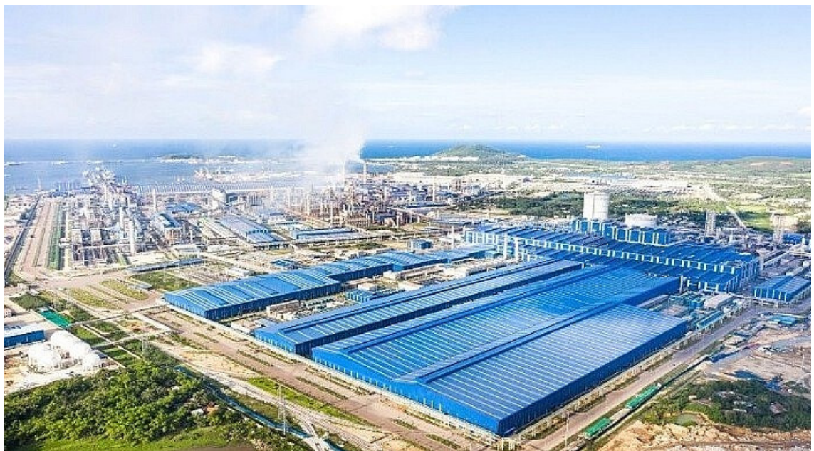
Nhà máy Dung Quất 2
