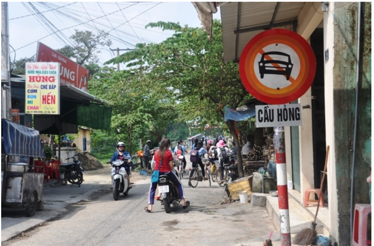
Cầu Phú Lưu ( phường Võ Dạ) bị hư hỏng nặng
