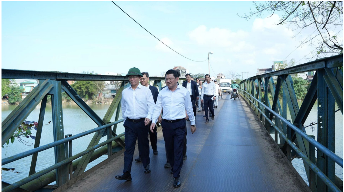
Cầu sắt Phú Lưu qua Cồn Hén sẽ được đầu tư xây dựng mới
