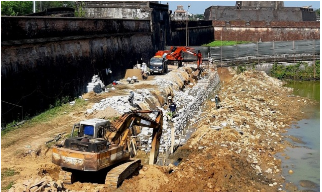
Dùng xe cơ giới đào, xúc, xây kè bê tông cốt thép
