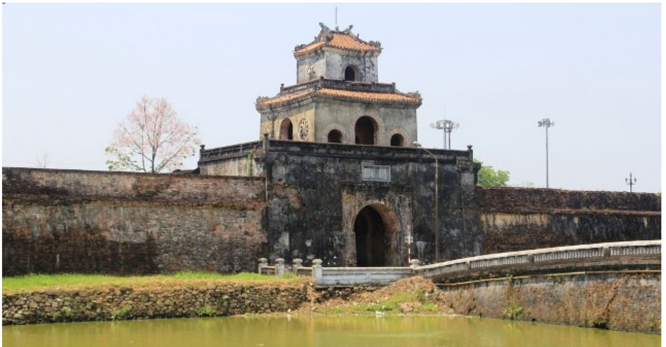
hình ảnh cũ - kỹ thuật xếp đá không dùng vữa
