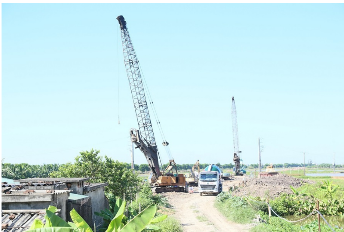
Khu vực thi công cầu vượt sông Trà Lý qua địa phận xã Trà Giang.
