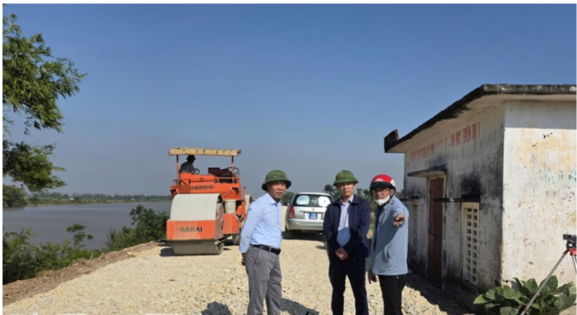
Các đơn vị đang đẩy nhanh tiến độ thi công
