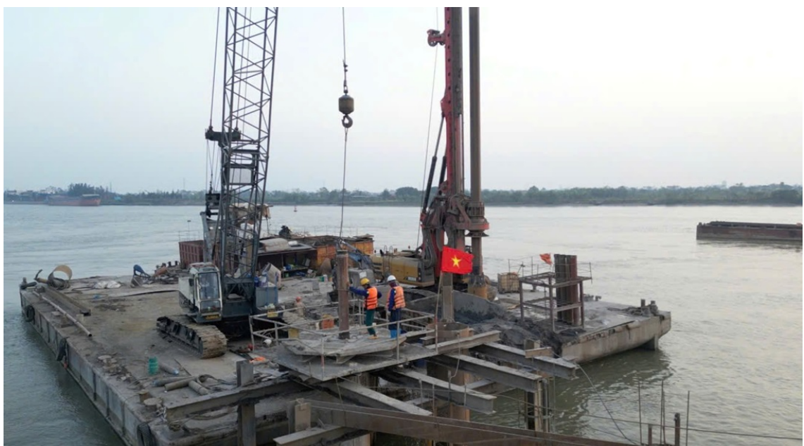
Đơn vị đang triển khai tuyến đường từ phường Thái Bình đi phường Phố Hiến
