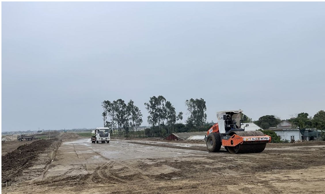
Máy móc thi công tại một số dự án giao thông trọng điểm trên địa bàn tỉnh.
