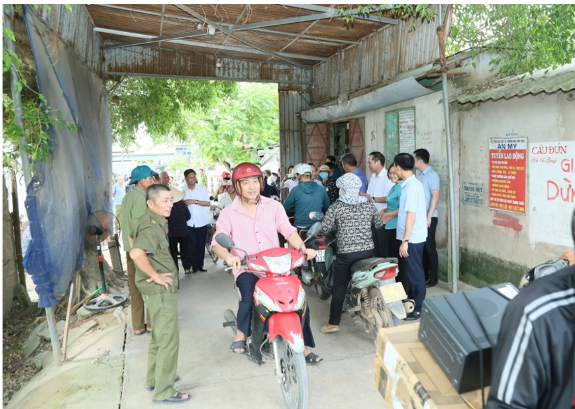
Điểm thu phí cầu Đún được tháo dỡ
