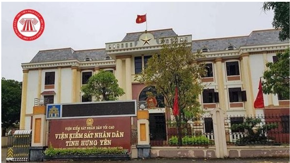
Viện Kiểm sát Nhân dân tỉnh Hưng Yên
