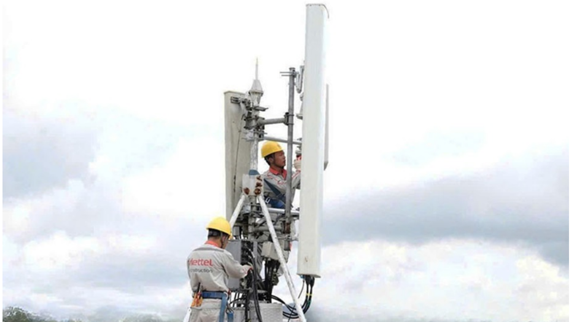
Nhân viên kỹ thuật của Viettel Hưng Yên lắp đặt các trạm phát sóng 5G tại Khu công nghiệp Liên Hà Thái.
