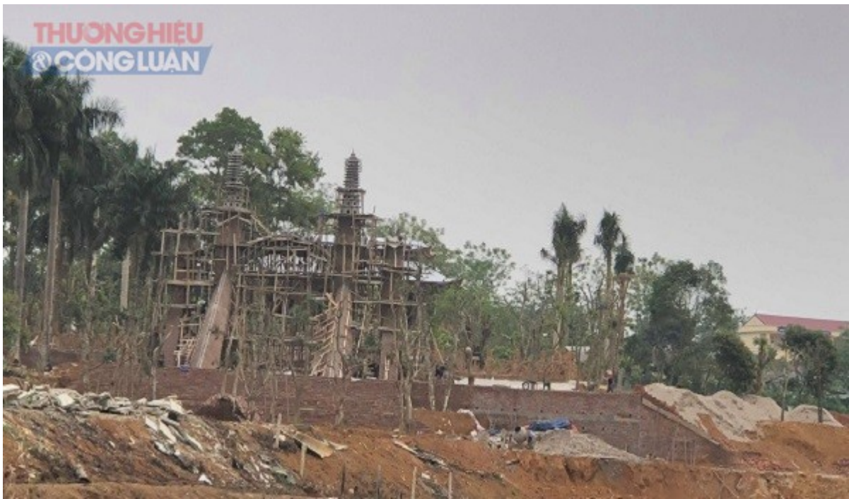
Toàn cảnh công trình
