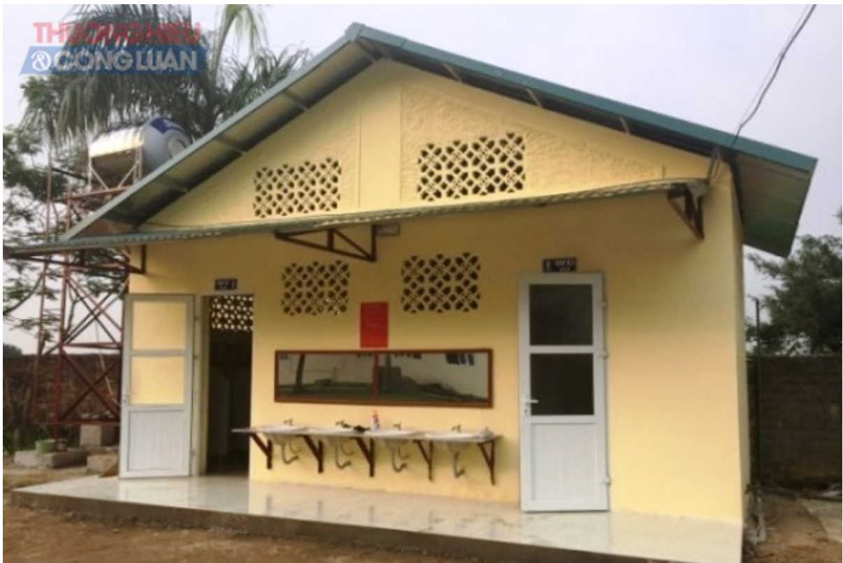
Nhà vệ sinh tại Trường THCS Nghĩa Hưng đã đưa vào sử dụng
