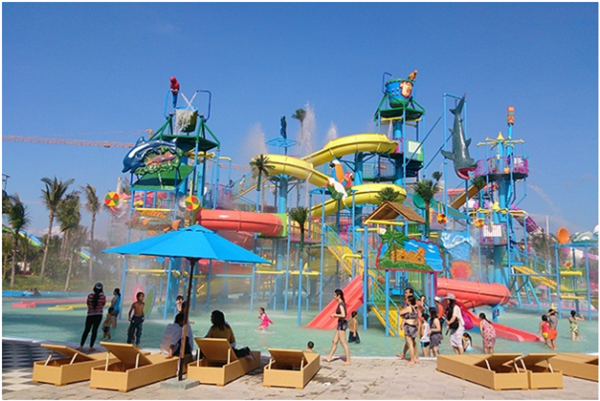
Công viên nước Vinperlland Phú Quốc do HVC cung cấp, lắp đặt
