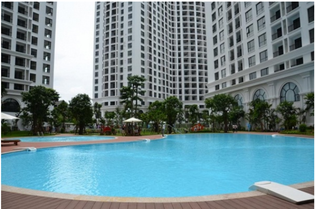
Bể bơi Thông minh Royal City do HVC cung cấp, lắp đặt
