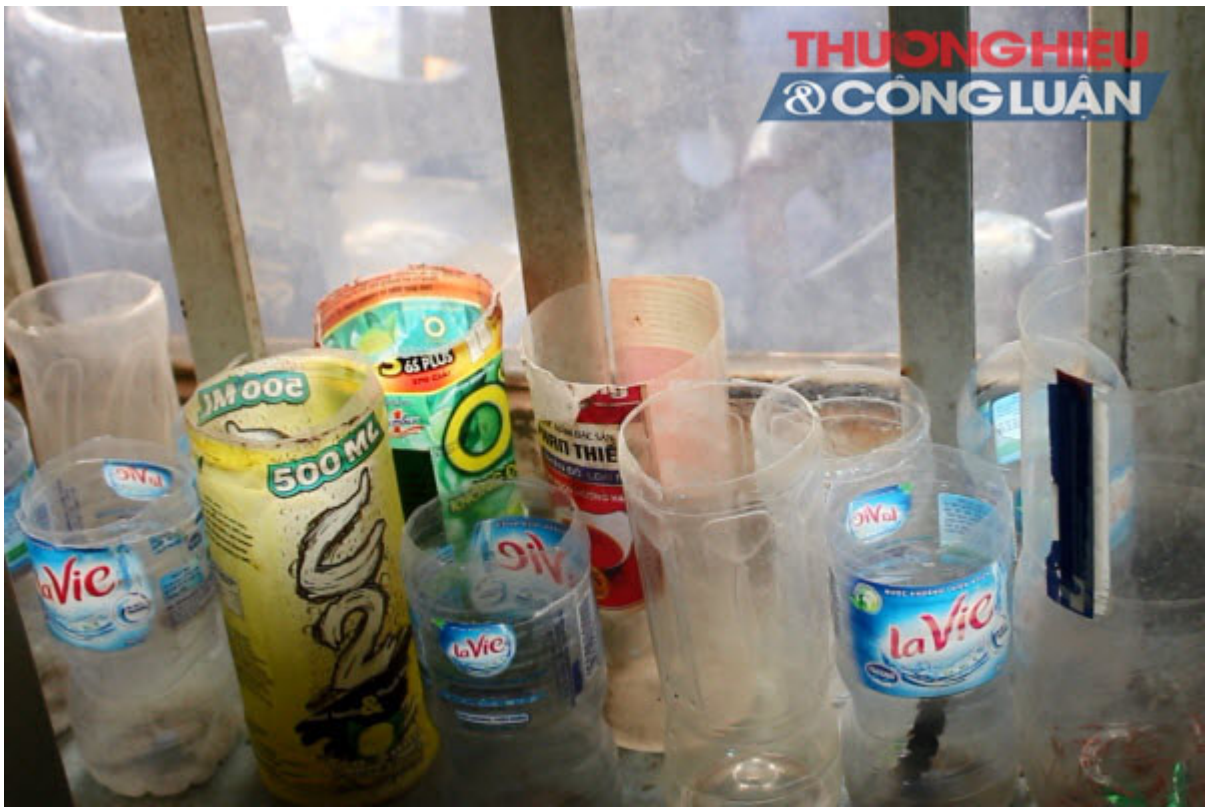
Mưa thấm, dột vì doanh nghiệp “không dám” sửa chữa văn phòng công ty (Ảnh: Nguyễn Lánh)
