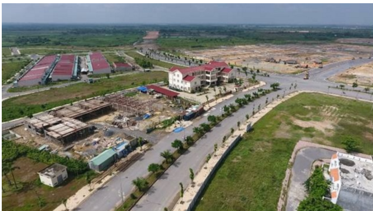
Những công trình tại Dự án Long Hưng đang dần được hoàn thiện
