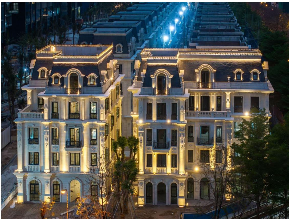
Dự án đang bước vào giai đoạn hoàn thiện cuối cùng (Ảnh: Noble Palace Tay Ho)
