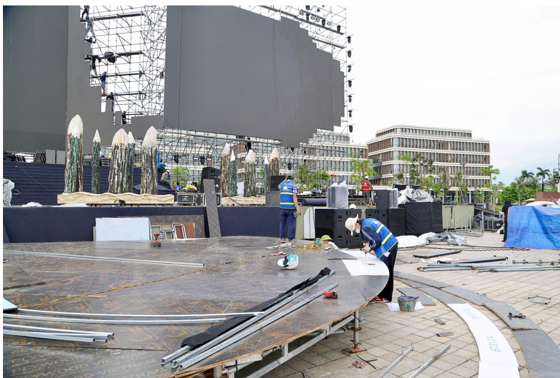
Hệ thống sân khấu đang được khẩn trương lắp đặt.
