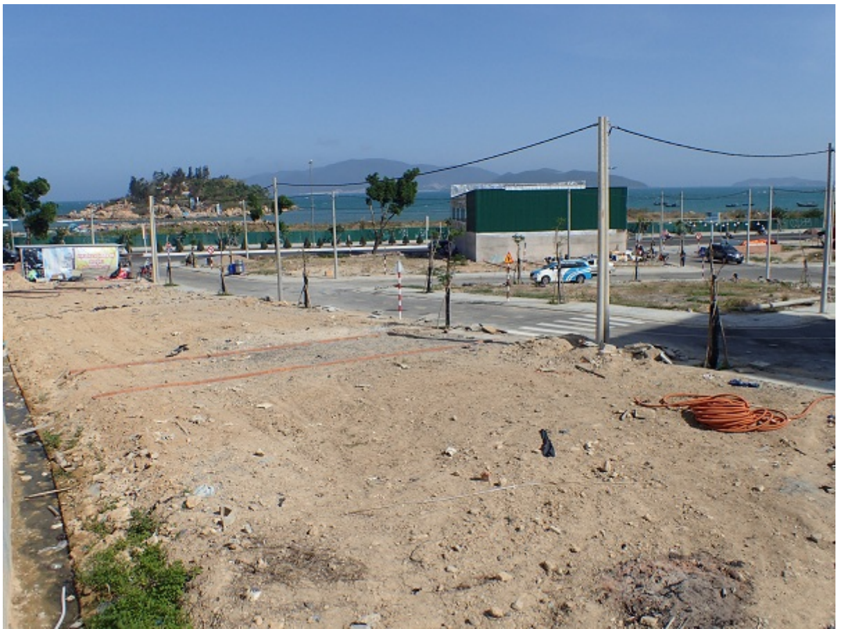
Dự án KDC tổ 32- 33 Vĩnh Thọ, TP Nha Trang tháng 3/2018
