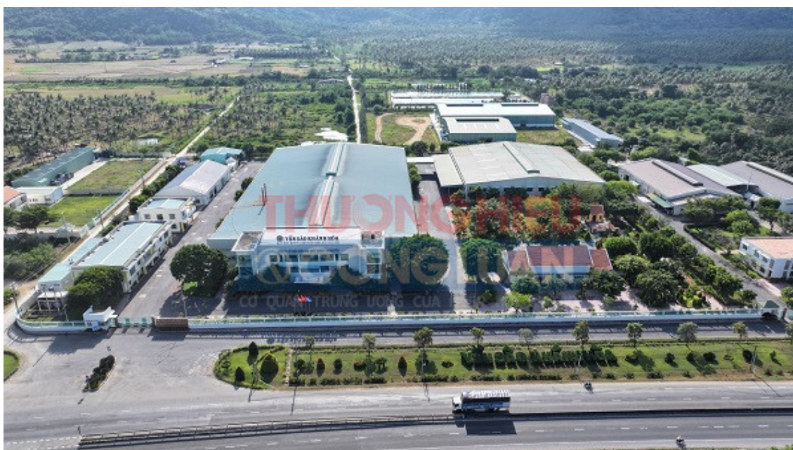
Nhà máy nước giải khát cao cấp Yến sào- Công ty CP nước giải khát SANEST Khánh Hòa (thuộc Yến sào Khánh Hòa) (Ảnh: Trần Minh Ngọc)
