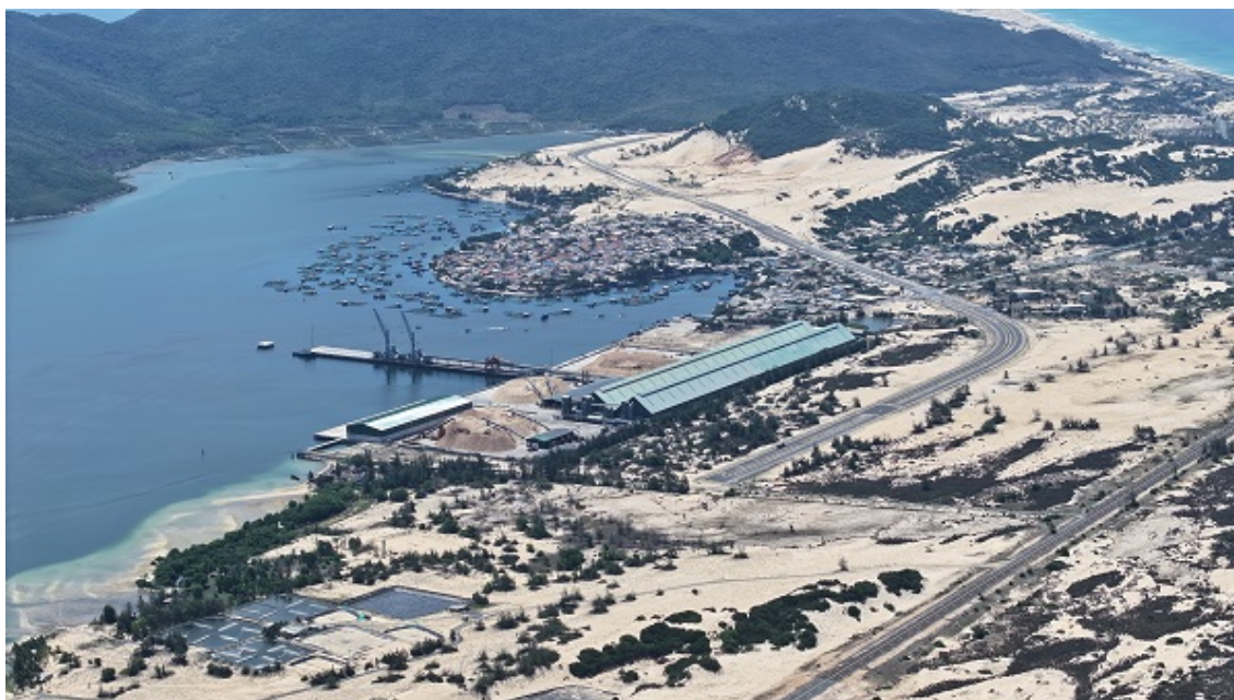
Cảng trung chuyển Quốc tế Vân Phong (Đầm Môn, Bắc KKT Vân Phong) Khánh Hòa (Ảnh: Trần Minh Ngọc)
