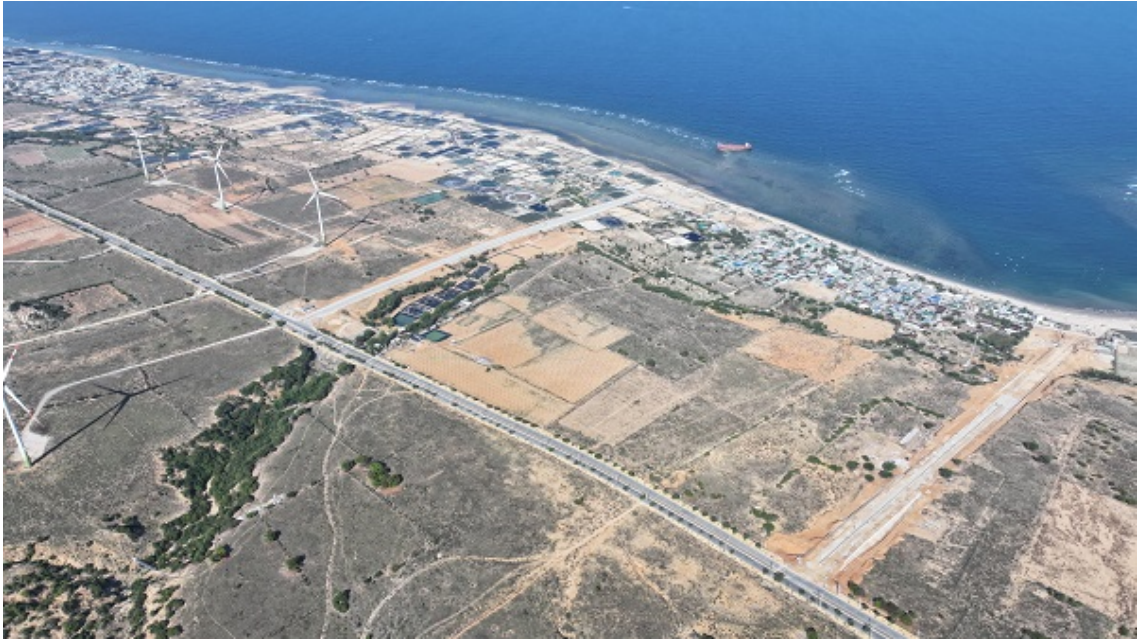
Khu vực xây dựng Nhà máy Điện hạt nhân Ninh Thuận 1, tại xã Phước Dinh, Khánh Hòa (Ảnh: Trần Minh Ngọc)
