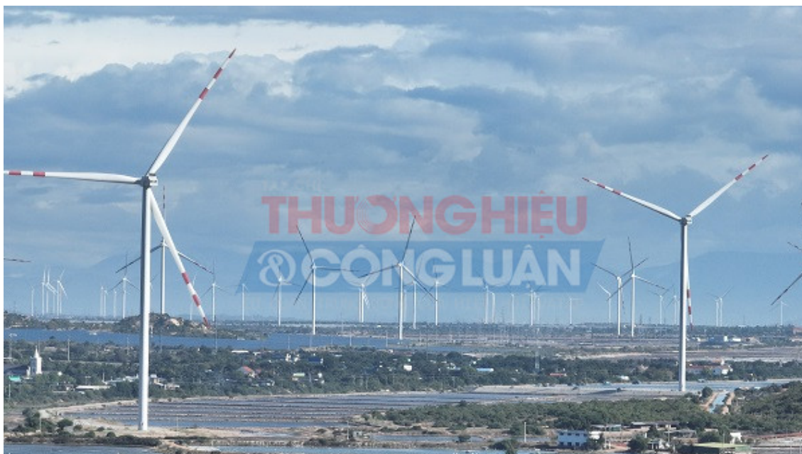
Các dự án điện gió tại khu vực xã Cà Ná (Ảnh: Trần Minh Ngọc)
