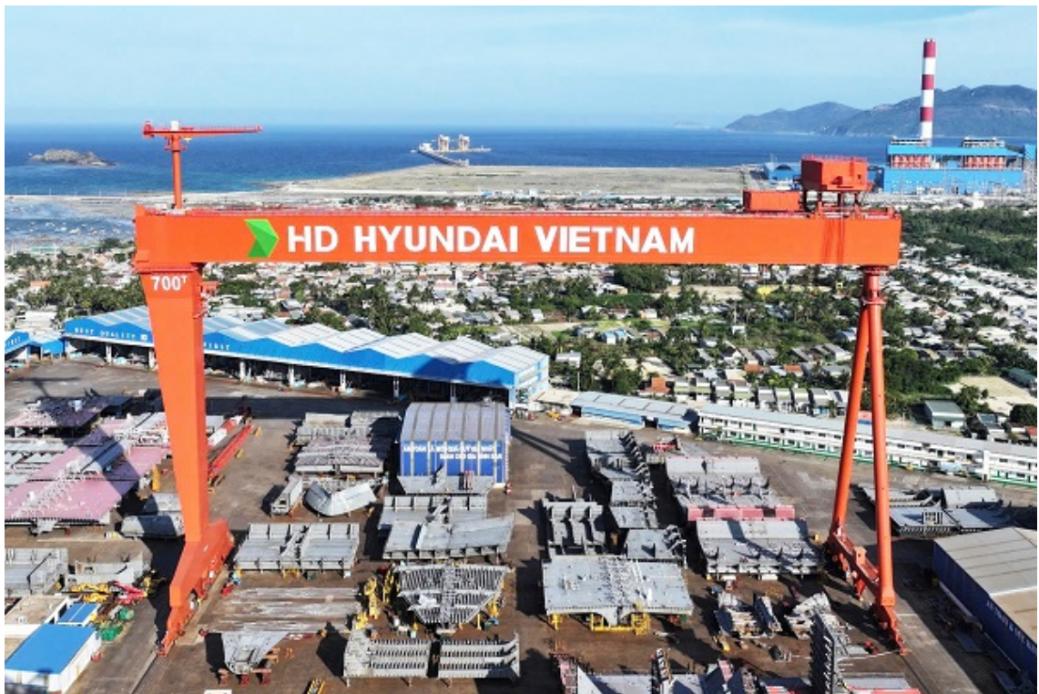
Cần cẩu Goliath 700 tấn được HVS đầu tư lắp đặt từ năm 2022 (Ảnh: KT)
