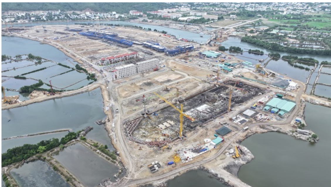
Dự án Khu đô thị hỗn hợp Nha Trang tại phường Nam Nha Trang đang thi công (Ảnh: Trần Minh Ngọc)
