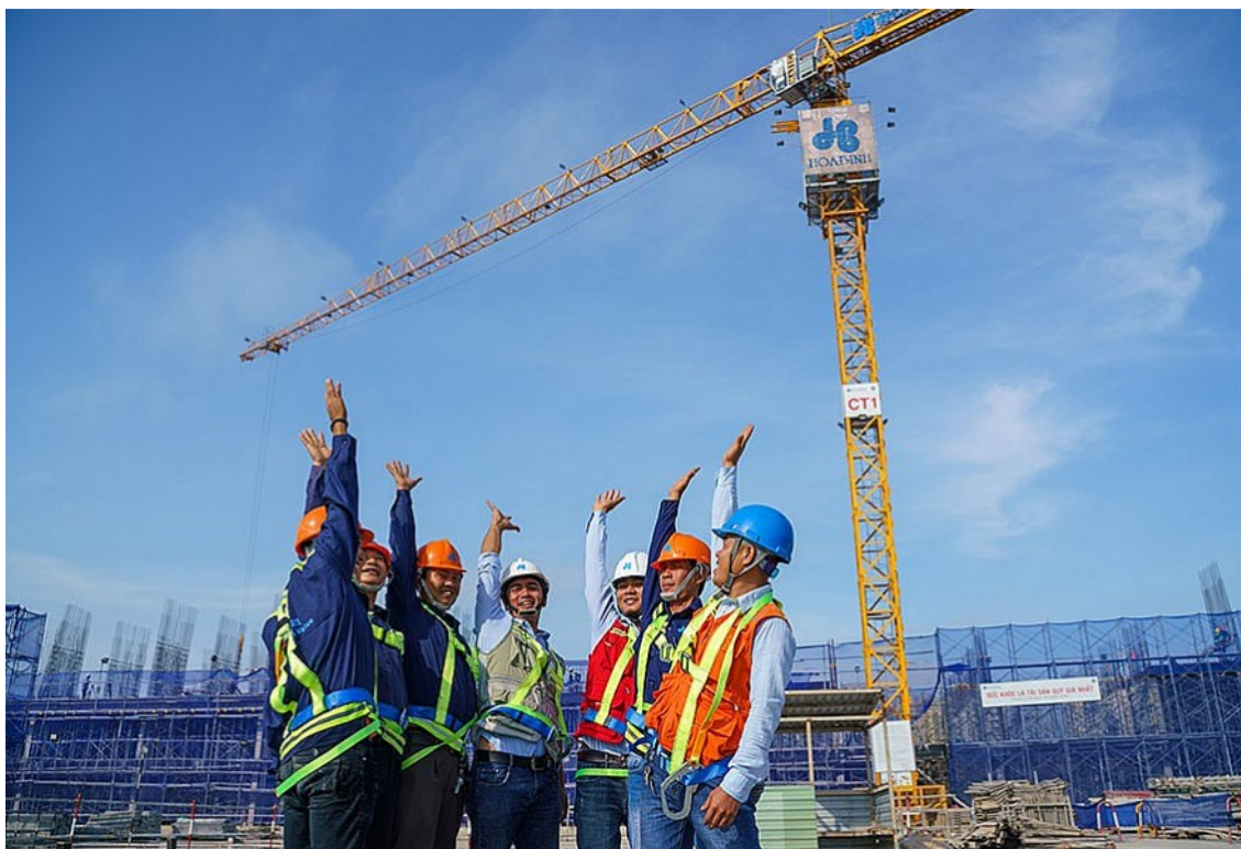
Đội ngũ kỹ sư và công nhân của Tập đoàn Xây dựng Hòa Bình tại một dự án trên địa bàn Hà Nội
