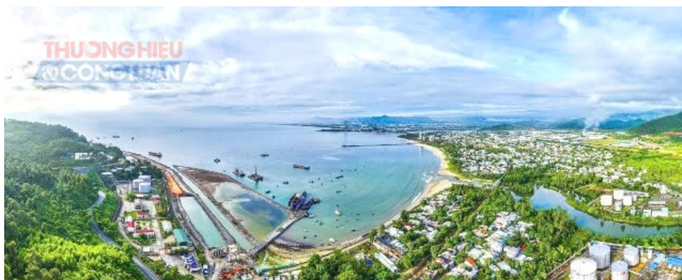
Thi công Bến cảng Liên Chiểu (phần cơ sở hạ tầng dùng chung).
