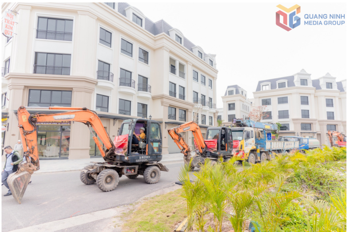
Đơn vị thi công bắt đầu triển khai xây dựng. (Ảnh: QMG)
