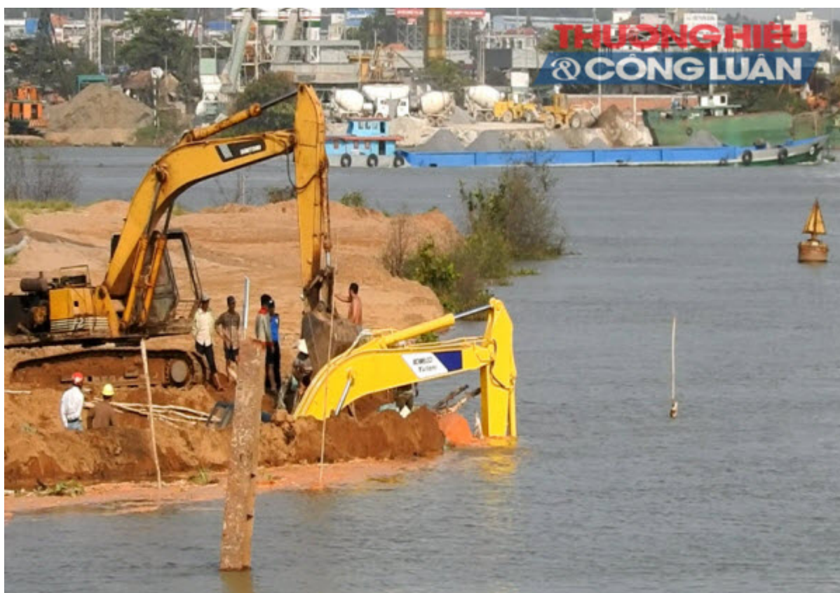
Dự án KDC - dịch vụ và du lịch cù lao Tân Vạn đã tạm dừng thi công (Ảnh: Nguyễn Lánh)
