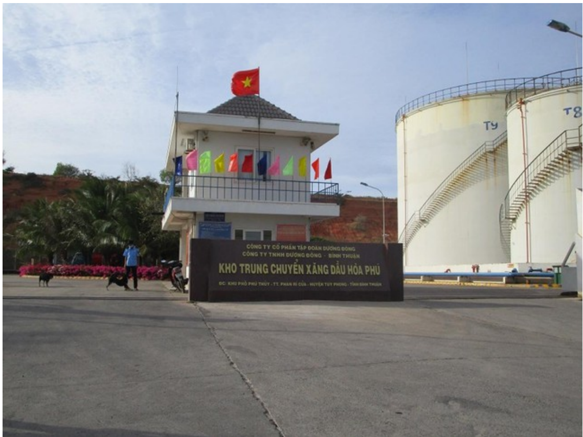
Kho trung chuyển xăng dầu của Công ty Cổ phần xăng dầu Dương Đông Hòa Phú.
