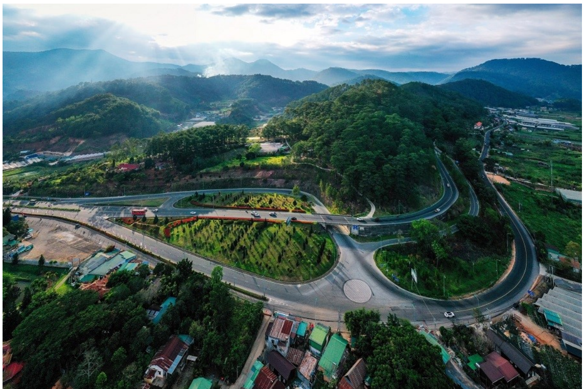
Nút giao thông tại chân đèo Prenn - Đà Lạt
