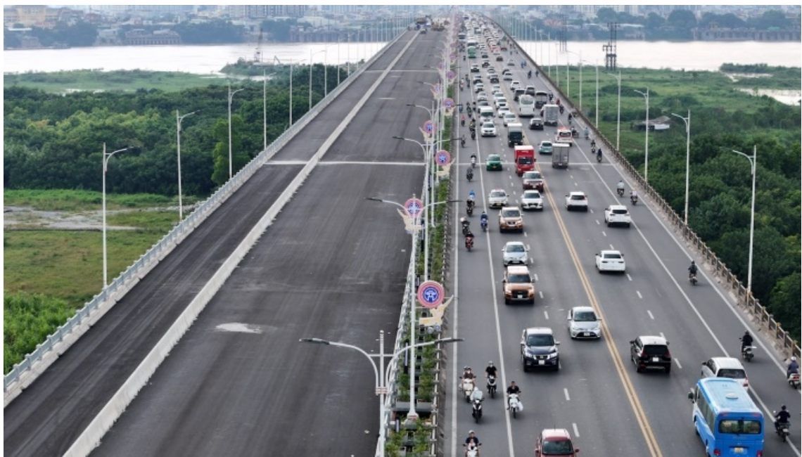
Cầu Vĩnh Tuy giai đoạn 2
