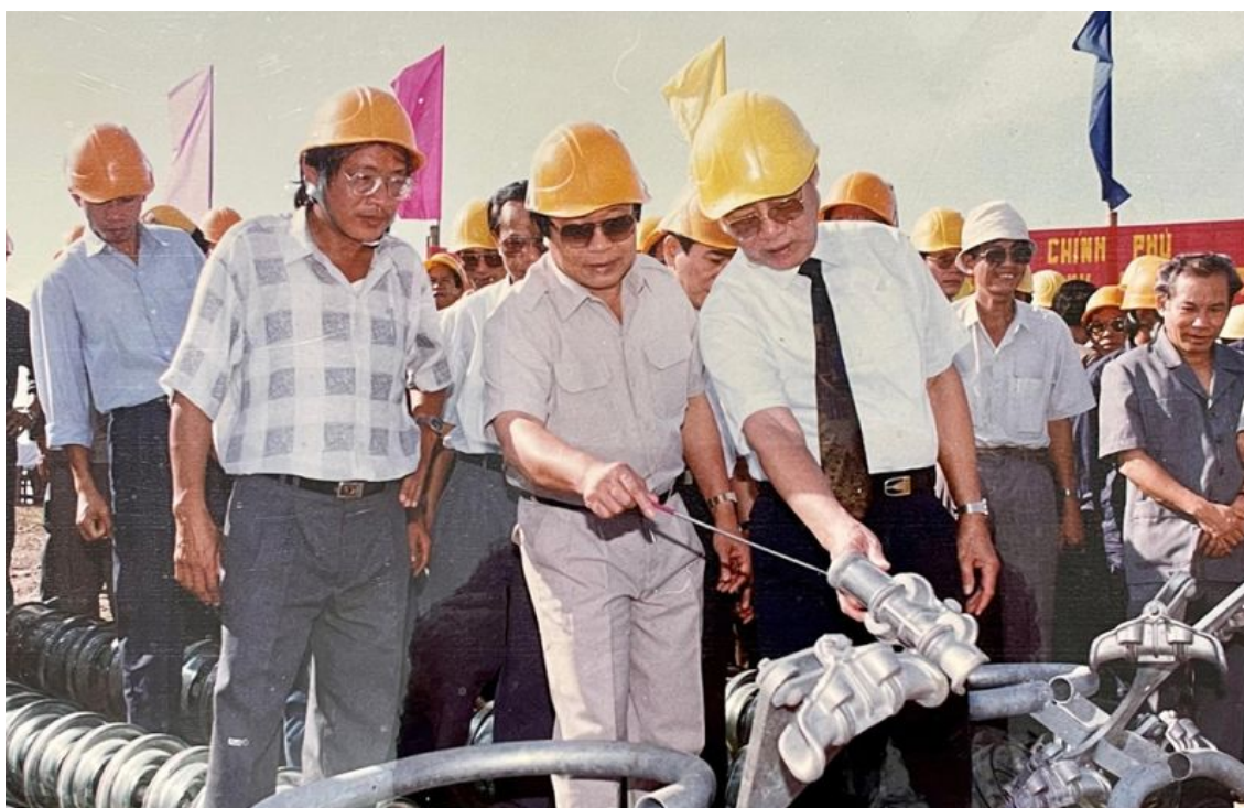
Thủ tướng Võ Văn Kiệt thị sát công trường thi công đường dây 500kV Bắc - Nam
