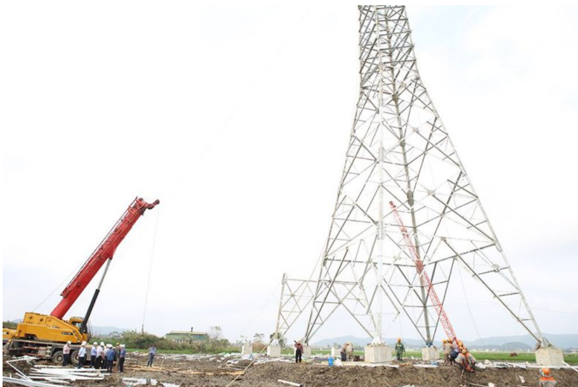
Thi công dựng cột Đường dây 500 kV mạch 3 Quảng Trạch - Phố Nối với phương châm “móng không đợi cột, cột không đợi dây”
