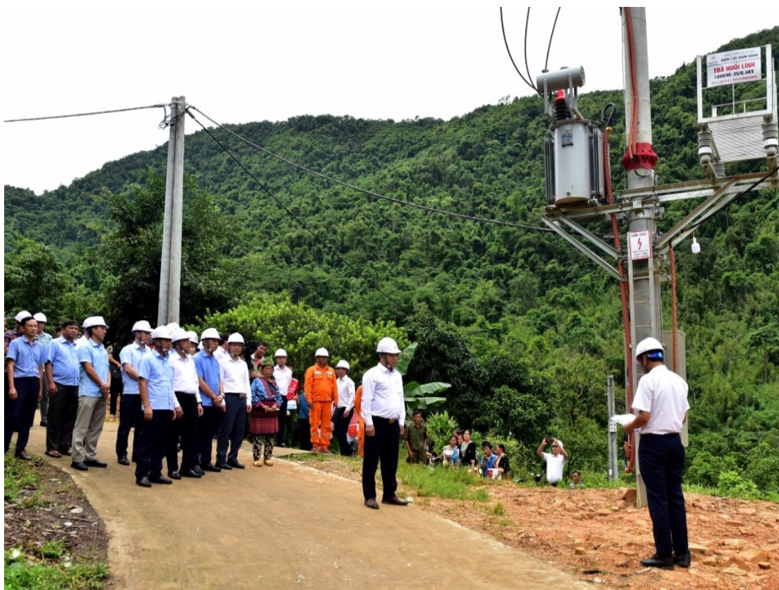
Nghi thức đóng điện trạm biến áp Huổi Lính
