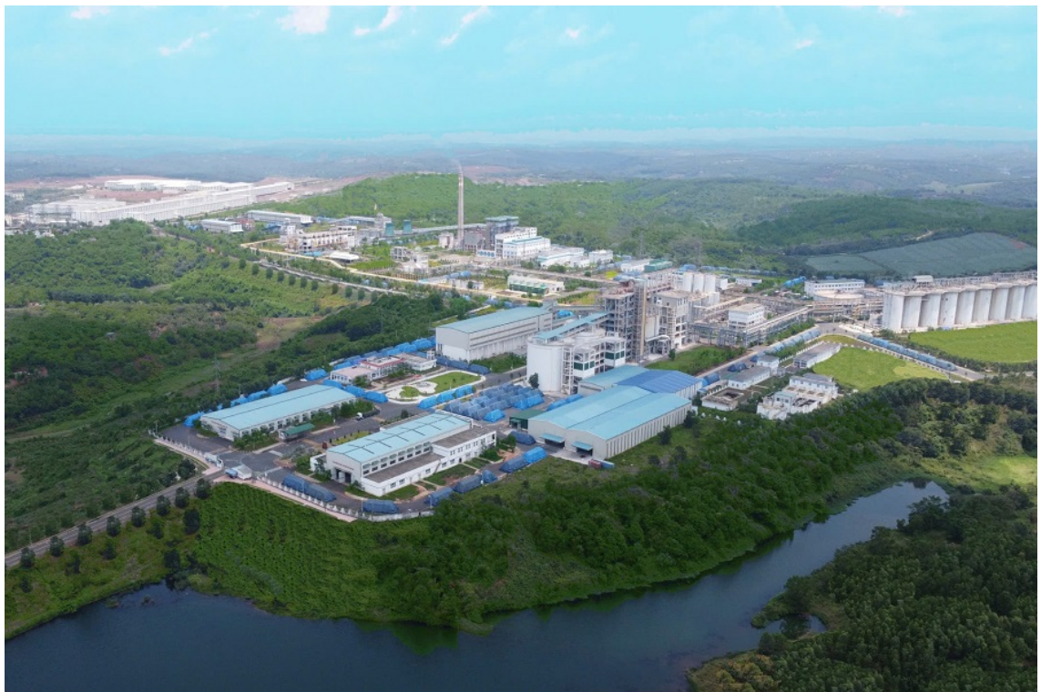
Công ty Nhôm Đắk Nông - TKV nhìn từ trên cao
