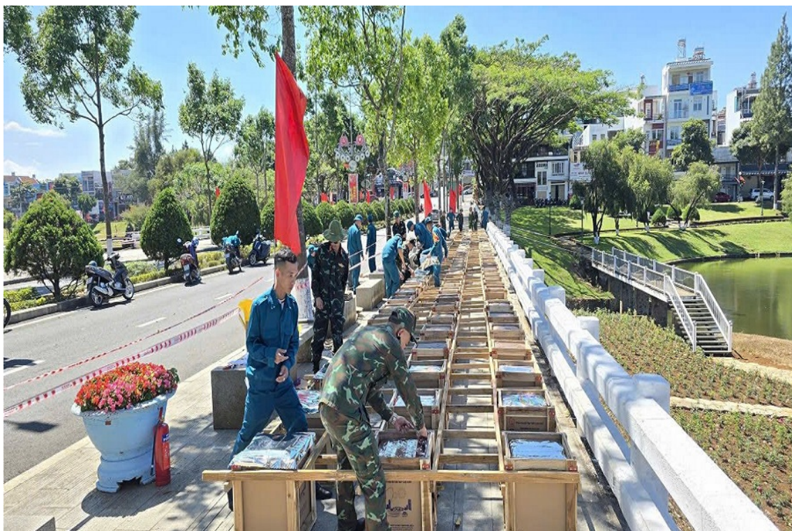
Lắp đặt, đấu nối kỹ thuật giàn pháo
