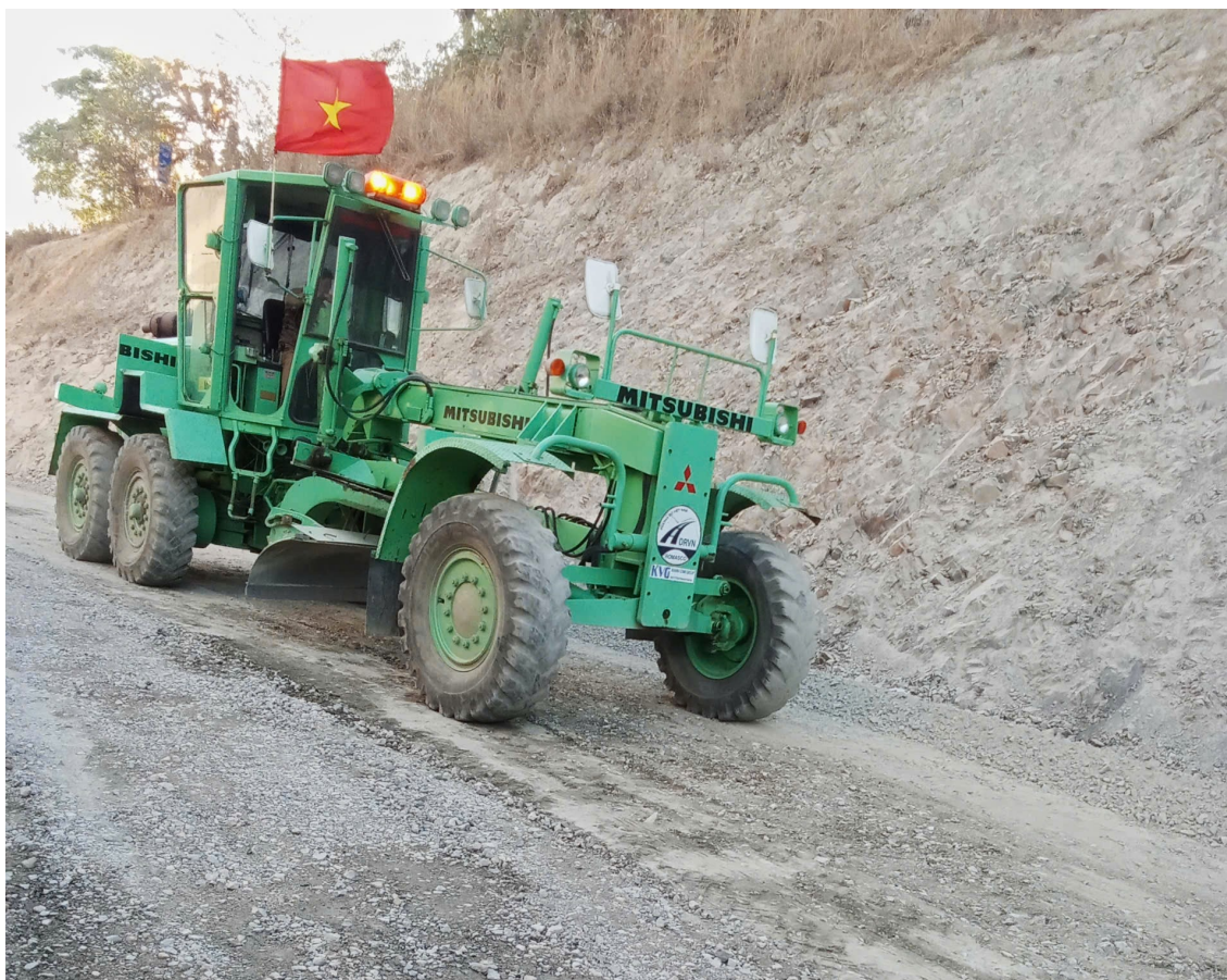
Đơn vị thi công tiến hành san, gạt khắc phục sự cố trên tuyến Quốc lộ 28B
