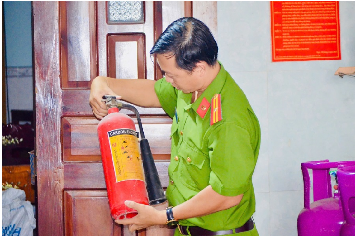
Thiếu tá Nguyễn Thái Minh, Tổ phó Tổ Cảnh sát khu vực, kiểm tra bình chữa cháy
