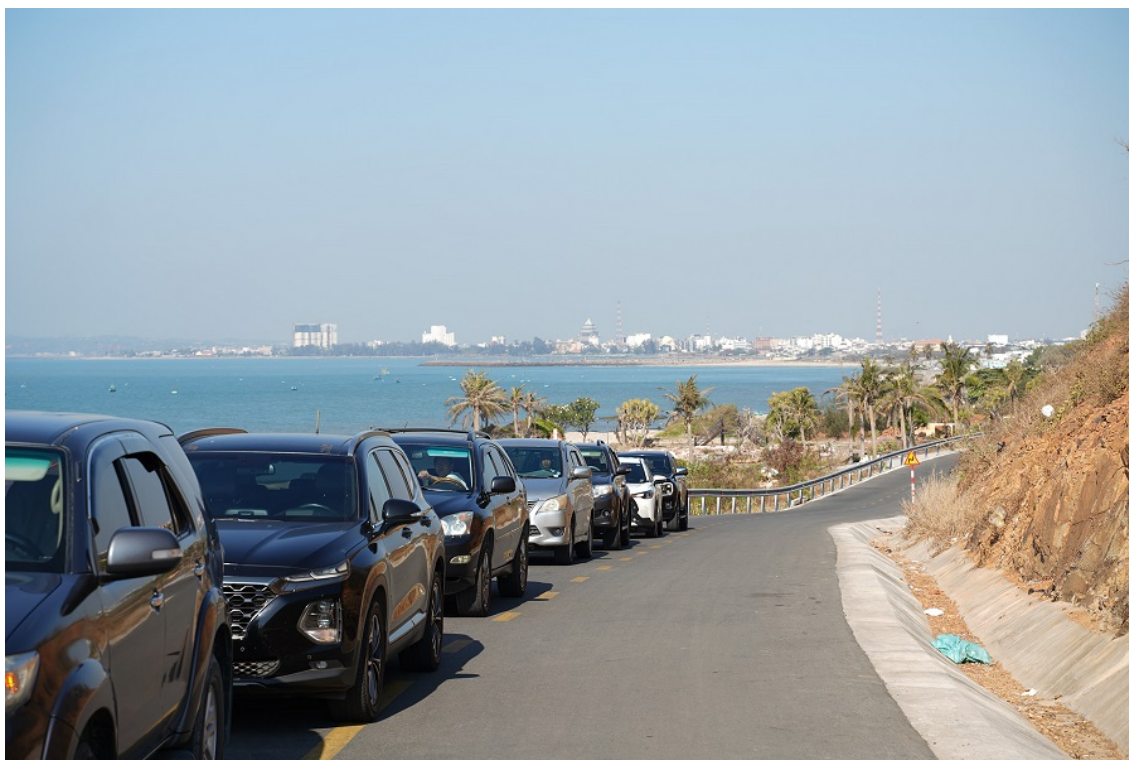
Tuyến đường ven biển dự kiến dài khoảng 14,6 km
