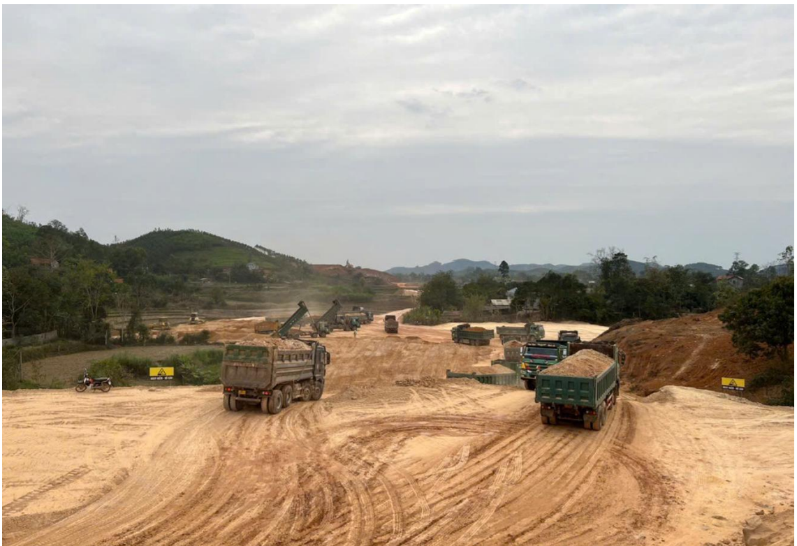
Thi công san lấp mặt bằng dự án khu công nghiệp VSIP Lạng Sơn trên địa bàn xã Hồ Sơn
