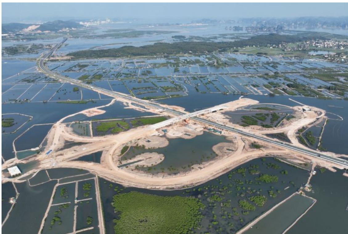
Nút giao Hạ Long Xanh được triển khai đầu tư trên diện tích 77,6 ha, thuộc phường Tân An, TX Quảng Yên, nối với cao tốc Hạ Long - Hải Phòng tại Km6+700. Ảnh: Đỗ Phương
