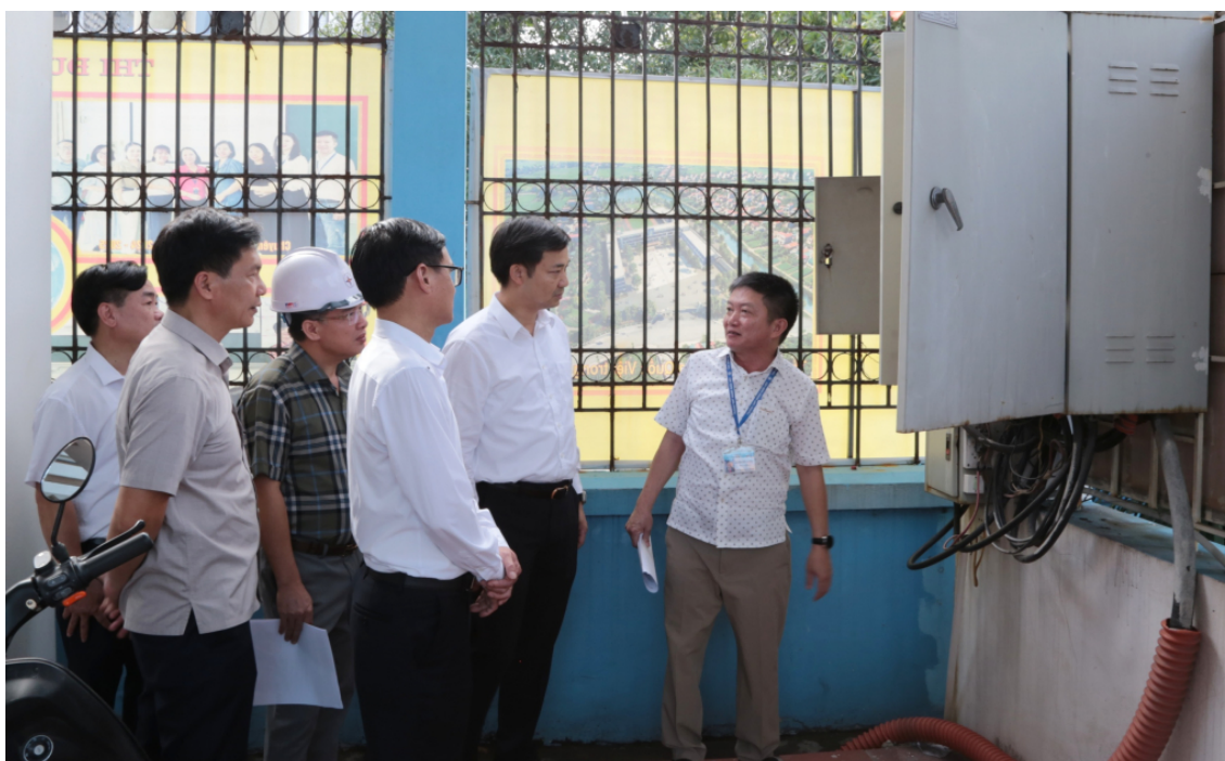
Đoàn công tác kiểm tra phương án đảm bảo cấp điện tại điểm thi Trường THPT Hoàng Quốc Việt
