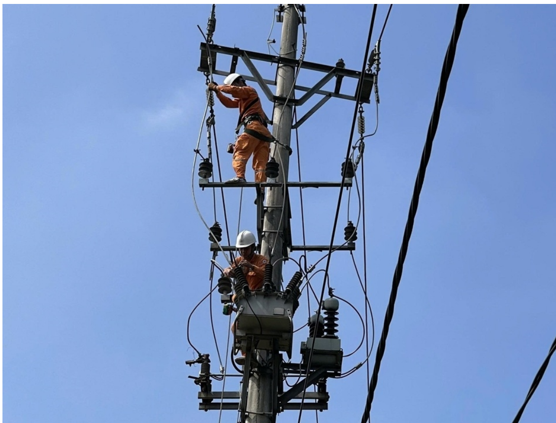
Công nhân PC Lào Cai thực hiện kết nối mạch vòng xuất tuyến trung áp sau TBA 110 kV
