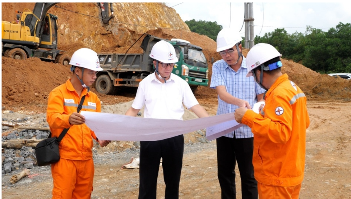
Lãnh đạo PC Lào Cai và đại diện nhà thầu kiểm tra bản vẽ thi công tại công trường xây dựng Trạm biến áp 110kV Bảo Hưng
