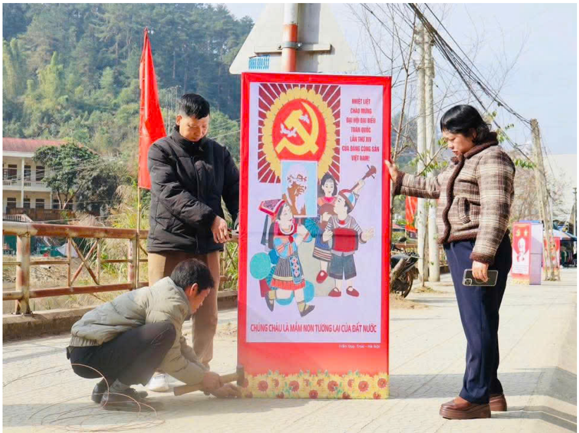
Triển khai thi công lắp đặt pano, áp phích tại xã Mù Cang Chải
