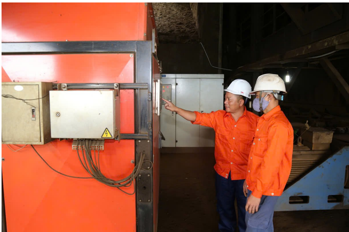
Công nhân kiểm tra máy móc, thiết bị tại nhà máy
