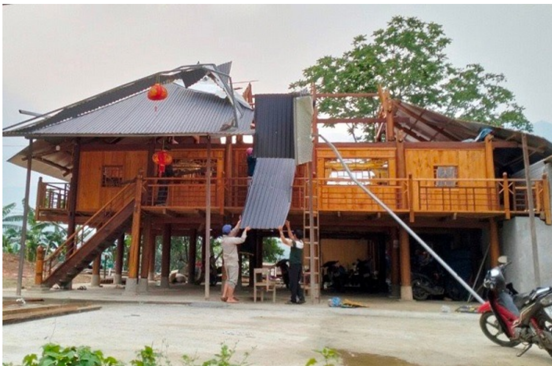
Dông lốc làm hư hỏng nhà dân tại Lào Cai.
