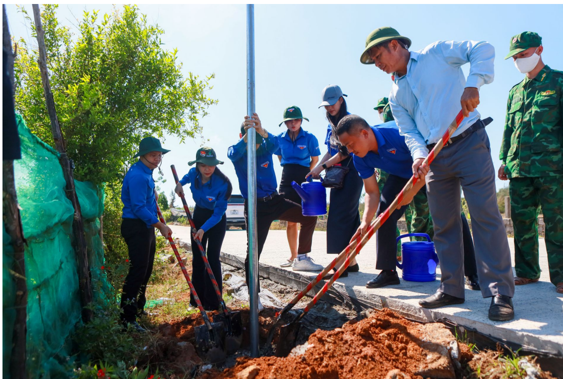
Tuổi trẻ BSR lắp đặt trụ đèn điện mặt trời trong công trình “Tuyến đường năng lượng mặt trời”
