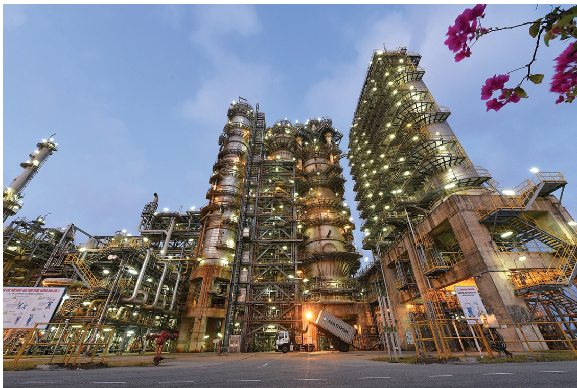
Phân xưởng RFCC thuộc Nhà máy Lọc dầu Dung Quất
