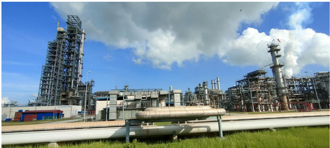
Nhà máy Lọc hóa dầu Nghi Sơn
