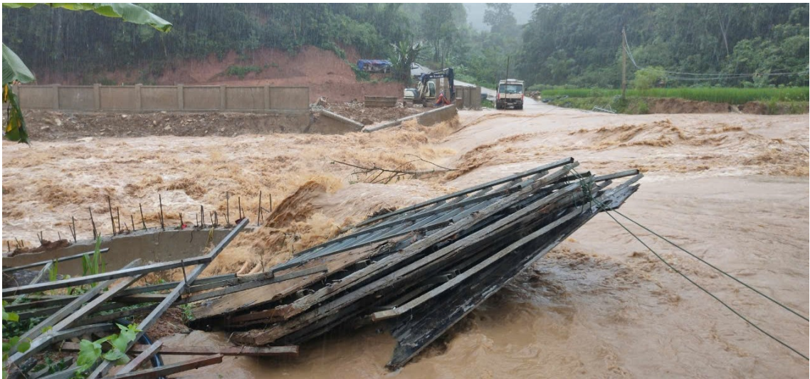
Mưa lũ gây sạt lở ở 152 vị trí trên các tuyến đường tỉnh tại Thanh Hóa
